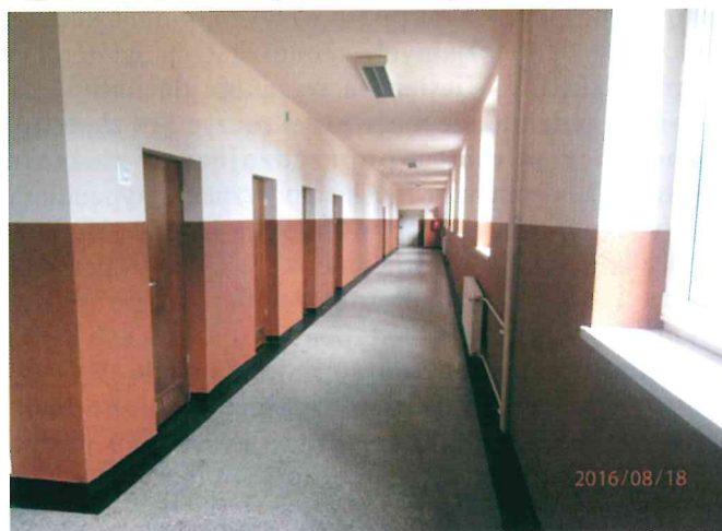
Parter od strony ulicy w ZPO Herby po remoncie
