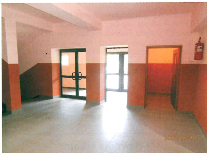
Wyjście z budynku szkoły w Herbach – po remoncie
