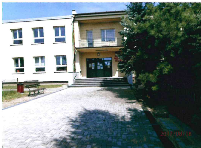
Wyremontowane wejście główne do budynku ZPO w Lisowie
