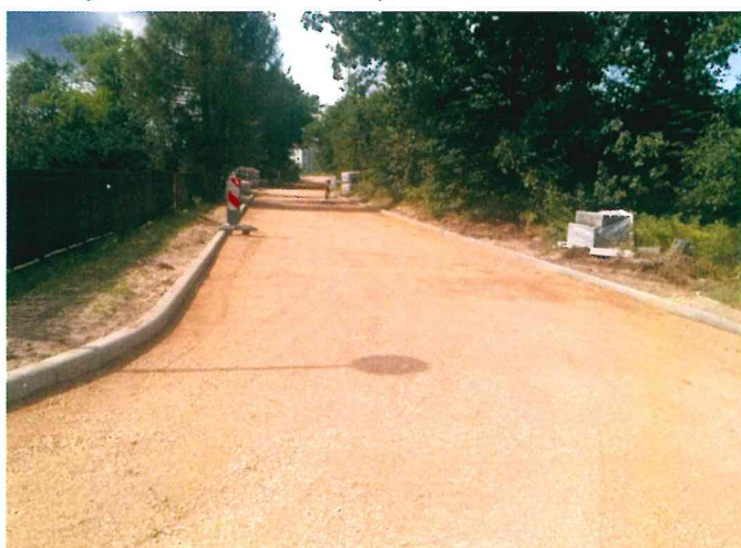
Modernizacja ulicy Podleśnej w Kalinie
