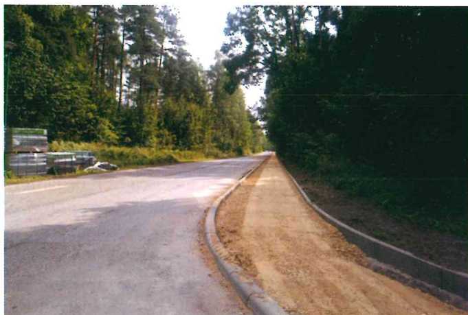
Modernizacja ul. Ogrodowej w Herbach
