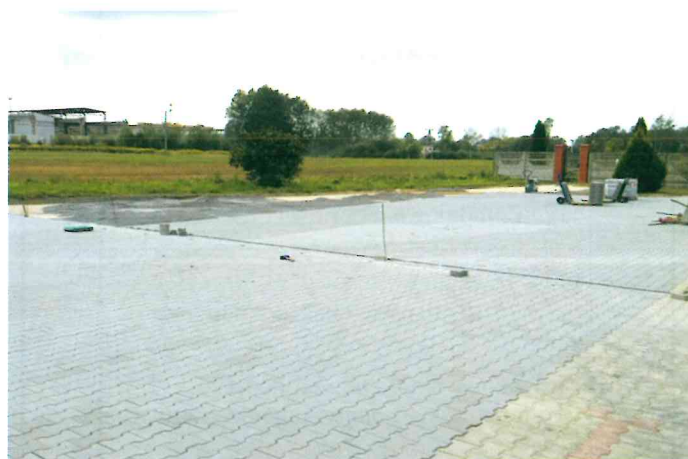
Budowa parkingu przy cmentarzu w Lisowie
