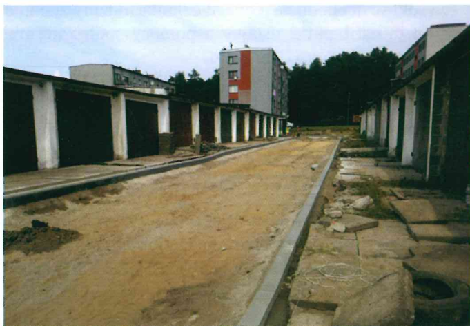
Modernizacja dróg wewnętrznych w Herbach ul. Leśna
