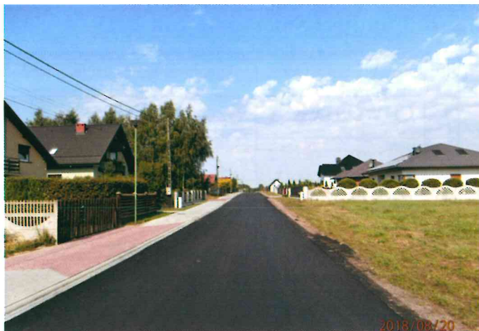
Ulica Szkolna w Hadrze po modernizacji
