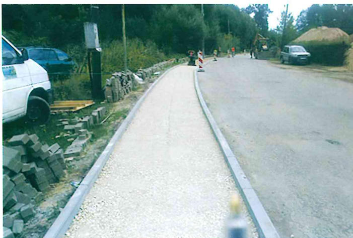
Remont chodnika przy ul. Piaskowej w Hadrze
