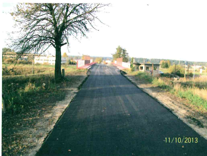
Remont nawierzchni mostu - część od Ameryki
