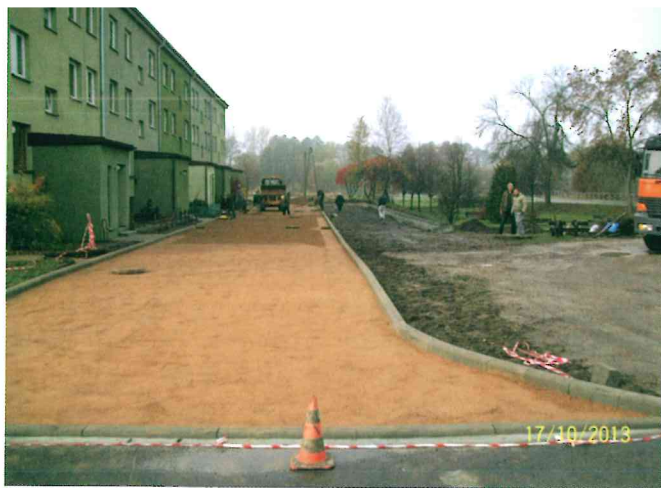
Remont chodnika przy bloku Budowlanych 15
