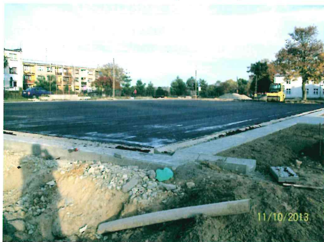
Budowa boiska z sztuczną nawierzchnią w Hadrze
