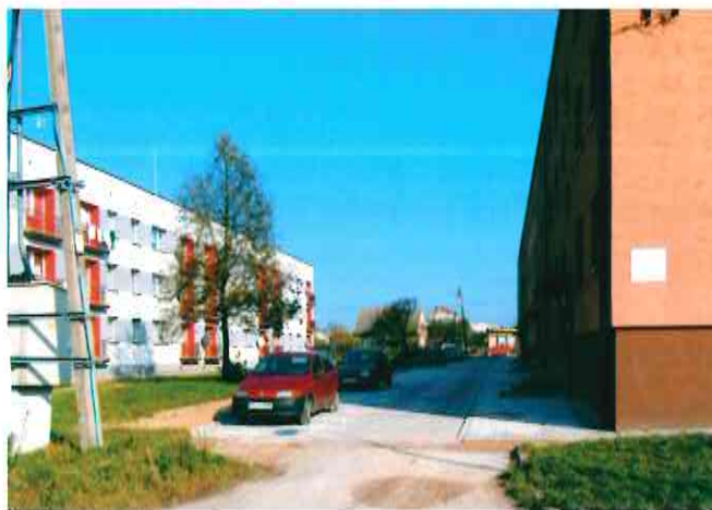
Droga przed blokiem Budowlanych 11
