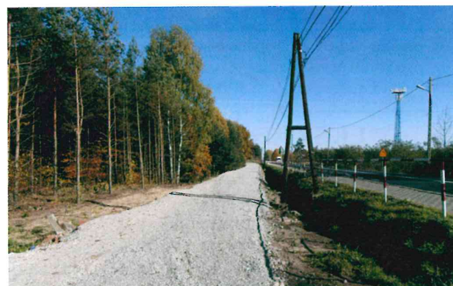
Początek ścieżki pieszo-rowerowej w kierunku Pietrzaków
