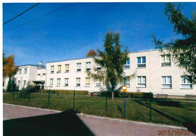
Ocieplenie dachu budynku szkoły w Lisowie - nad przedszkolem
