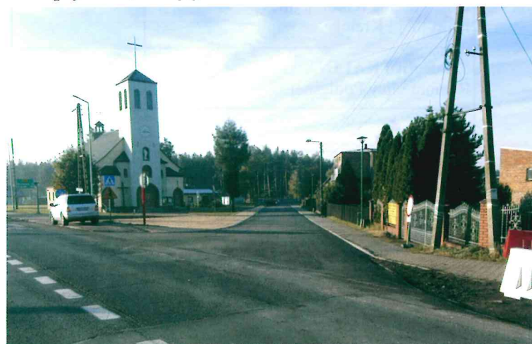
Część ulicy Nowej w Herbach po modernizacji
