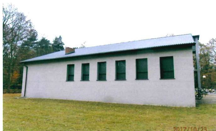
Wymiana okien w kaplicy na cmentarzu w Herbach
