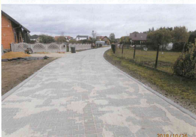
Ulica Orzechowa w Lisowie po modernizacji
