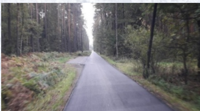
Wyremontowana droga do m. Braszczok
