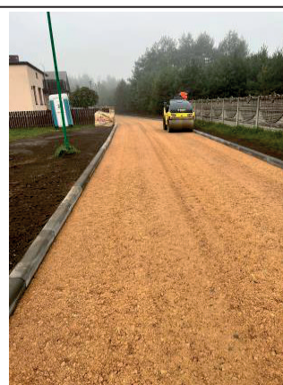
Modernizacja ul. Jałowcowej w Olszynie
