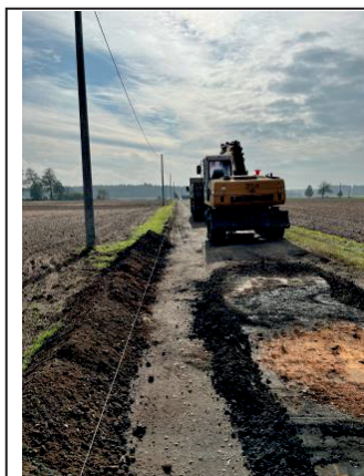
Droga dojazdowa do pól w Łębkach
