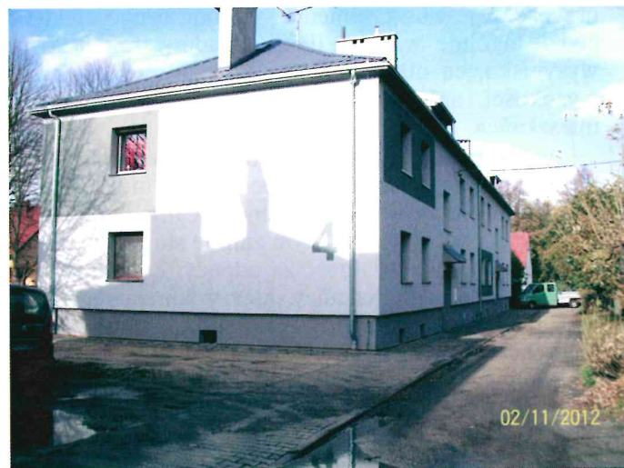
Budynek Wspólnoty Mieszkaniowej w Mochali po termomodernizacji
