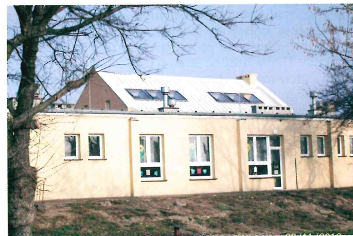
Zadaszone patio budynku przy ulicy Mickiewicza w Herbach
