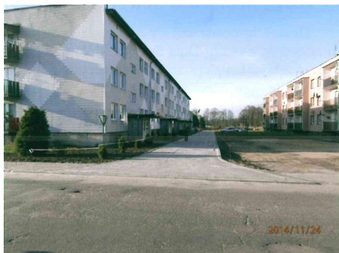
ul. Budowlanych 9 w Lisowie po modernizacji
