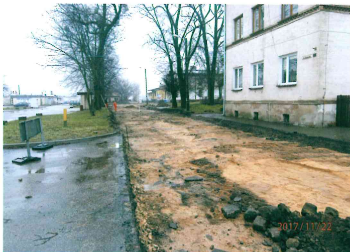
Rozpoczęcie modernizację ul. Dworcowej w Herbach
