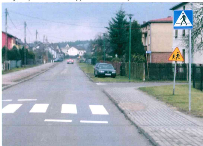
Nowo oznakowane przejście dla pieszych na ul. Stawowej w Lisowie
