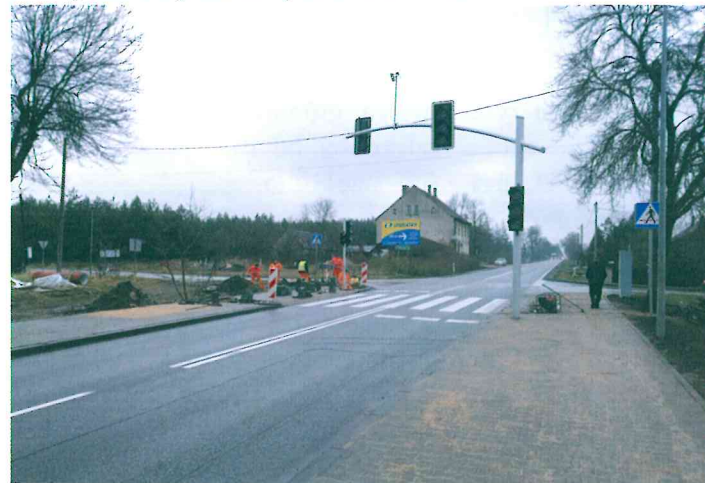
Budowa świateł na przejściu dla pieszych w Lisowie-droga nr 46
