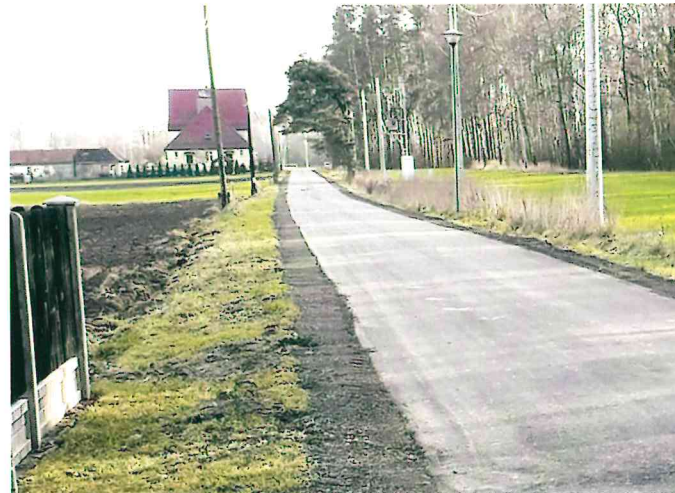
Nowa nawierzchnia na drodze w Braszczoku
