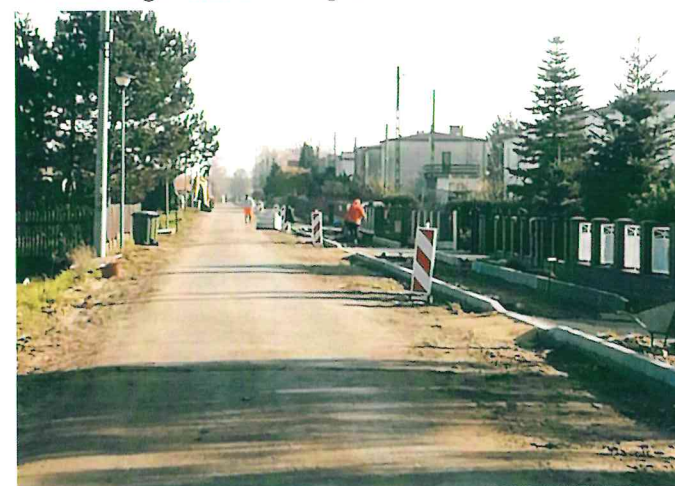
Trwa remont ulicy Fabrycznej w Mochali – budowa chodnika
