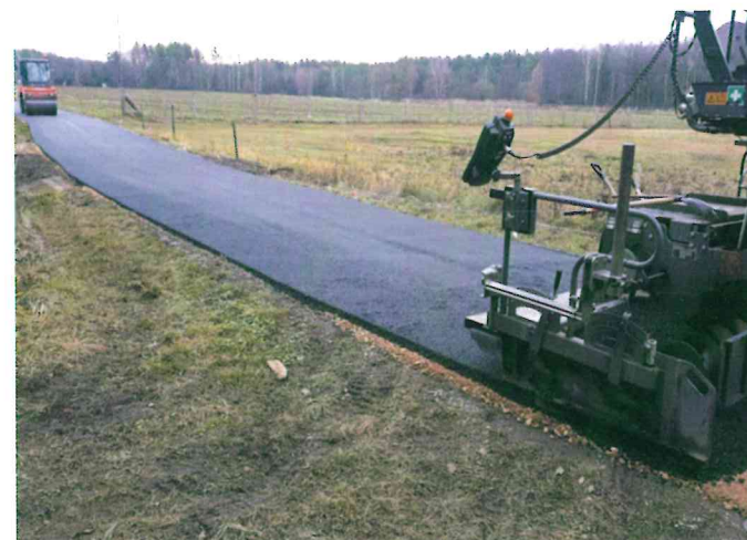
Remont drogi Oleksiki – Drapacz
