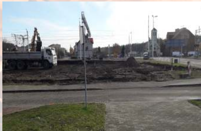
Zagospodarowanie centrum m. Herby – etap I budowa parkingu
