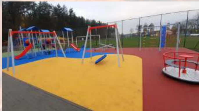
Plac zabaw w Herbach w trakcie budowy - uszkodzony przez wandalii
