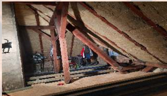
Docieplanie stropu i dachu w budynku Urzędu Gminy
