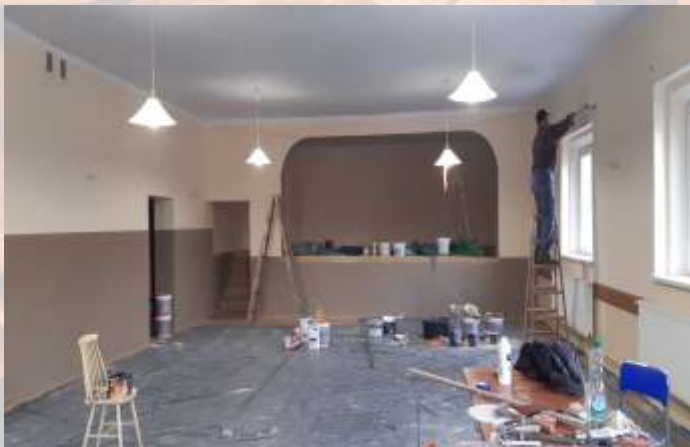
Remont sali w remizie OSP w Hadrze
