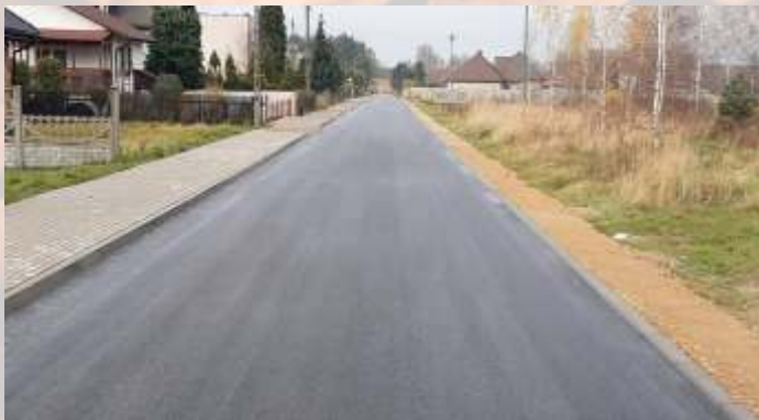
Ulica Fabryczna w Mochali po modernizacji
