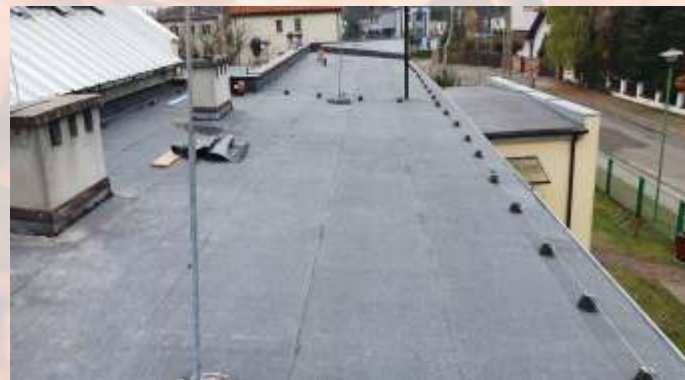
Remont dachu na budynku DPS w Herbach
