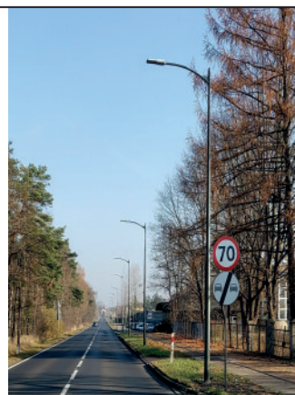
Nowe oświetlenie przy ul. Lublinieckiej w Herbach
