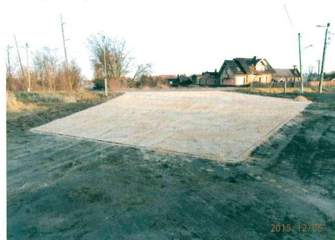
Modernizacja początku ul. Lompy w Kalinie
