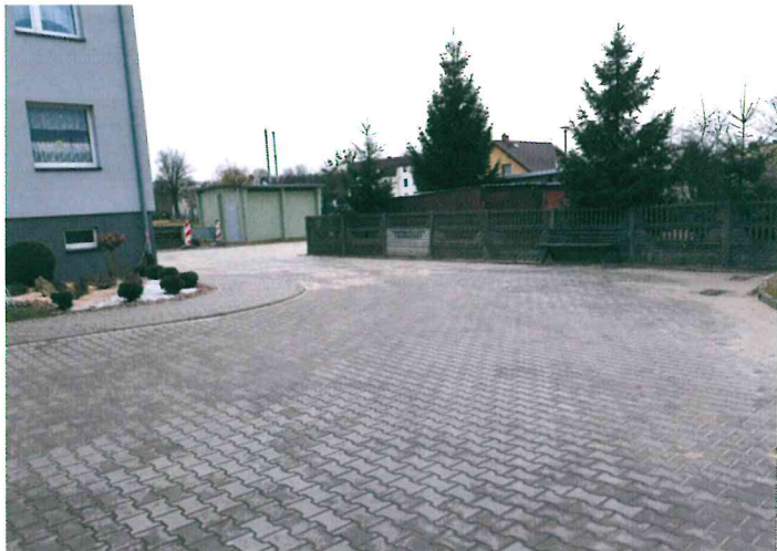
Nowa nawierzchnia na części ul. Witosa w Lisowie
