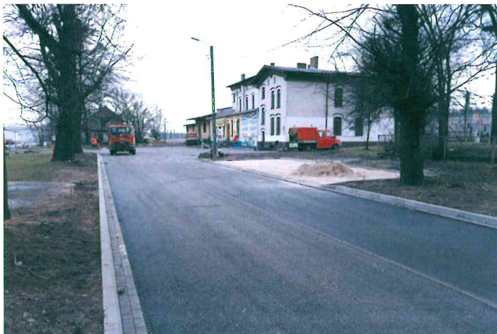
Ulica Dworcowa w Herbach w trakcie modernizacji
