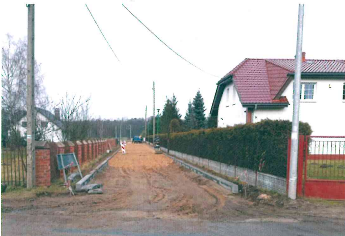
Modernizacja odnogi ul. Morcinka w Chwostku
