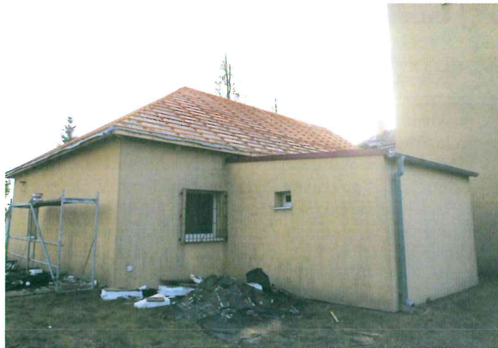
Modernizacja dachu na budynku remizy OSP w Olszynie
