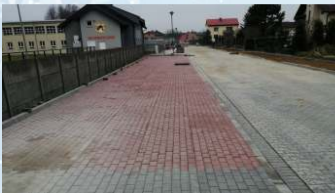
Przebudowa ul. Sportowej w Lisowie
