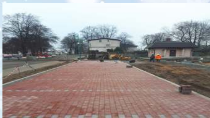
Budowa parkingu przy ul. Dworcowej w Herbach
