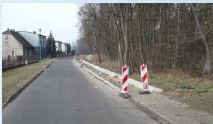
Budowa chodnika w Olszynie przy ul. Jałowcowej
