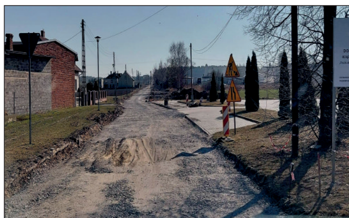
Budowa ul. Przemysłowej w Lisowie
