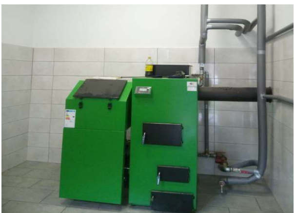
Wyremontowana kotłownia w OSP Tanina
