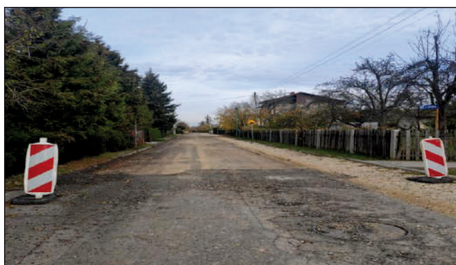
Modernizacja ul. Krótkiej w Herbach
