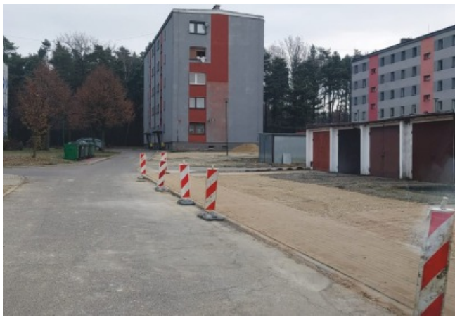
Nowy chodnik od bloku nr 18 do ul. Katowickiej
