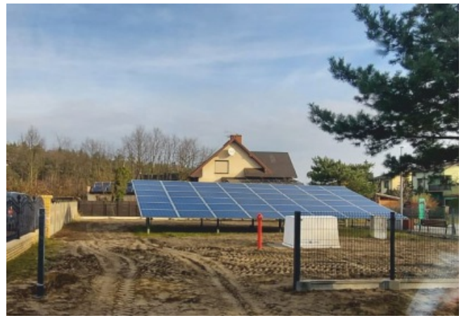
Nowa studnia 6a i jej ogrodzenie w Herbach
