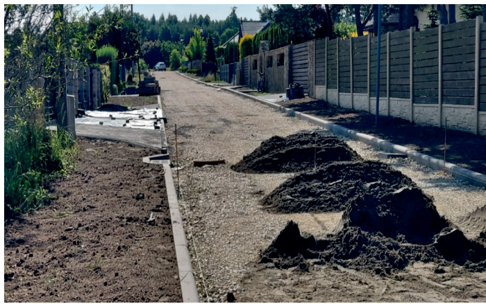
Modernizacja ul. Mokrej w Kalinie
