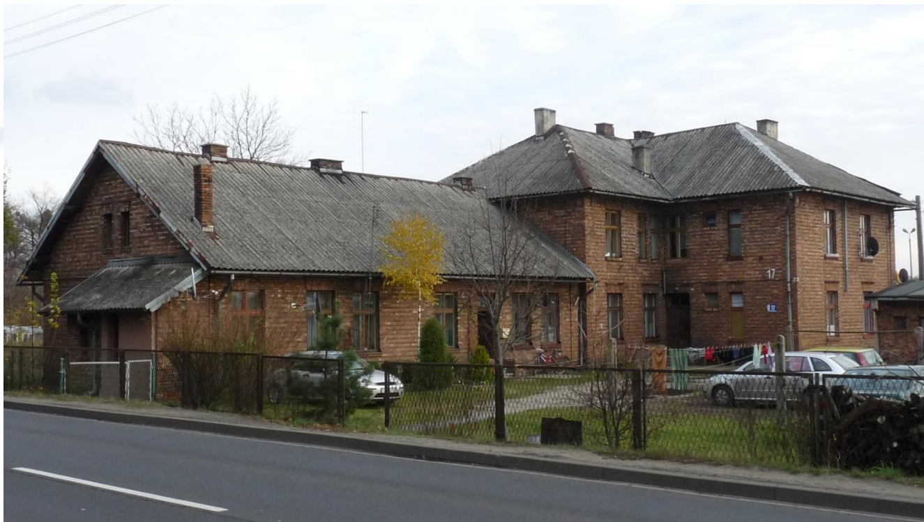
Rys. 3 Budynek pokryty falistymi płytami eternitowymi (foto: źródło własne)
