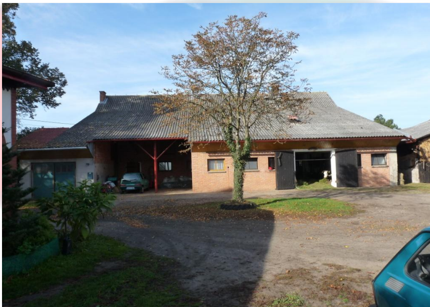
Rys. 7 Budynek obory położony w miejscowości Łebki, szacowana powierzchnia dachu to około 530 m 2 (fotografia: źródło własne)
