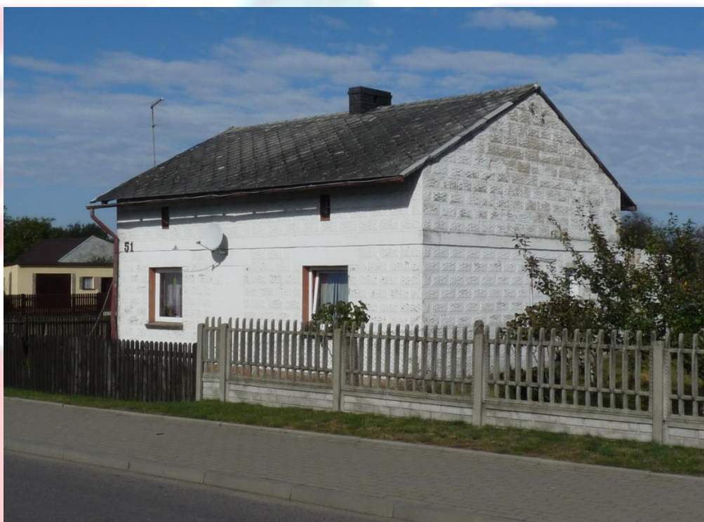
Rys. 2 Budynek pokryty płaskimi płytami eternitowymi (foto: źródło własne)
